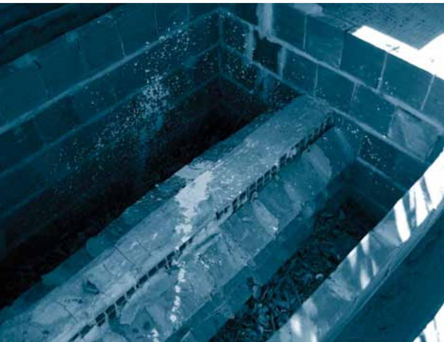
É importante construir a pirâmide de tijolos de forma que os furos estejam desobstruídos, apontando para as laterais. Assim o efluente pode alcançar as raízes das plantas.
