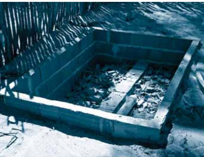
O efluente entra na pirâmide de tijolos e imediatamente inicia um processo de digestão anaeróbica. Ao alcançar os furos dos tijolos, ele entra em contato com o material poroso e as raízes das plantas, sendo digerido aeróbicamente.
